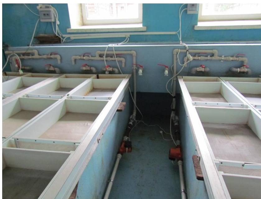
Obiegi półzamknięte ze stabilizacją temperatury do hodowli wylęgu
